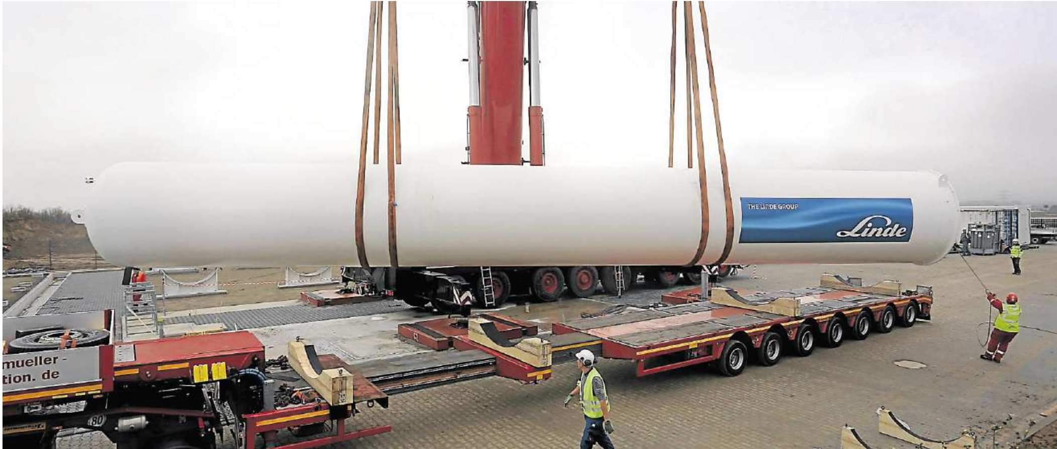
Zwei solcher Wasserstofftanks mit einer Länge von je 21 Metern und einem Durchmesser von 2,40 Metern – Gewicht: je 62 Tonnen – wurden von einem Spezialkran aufgestellt.
